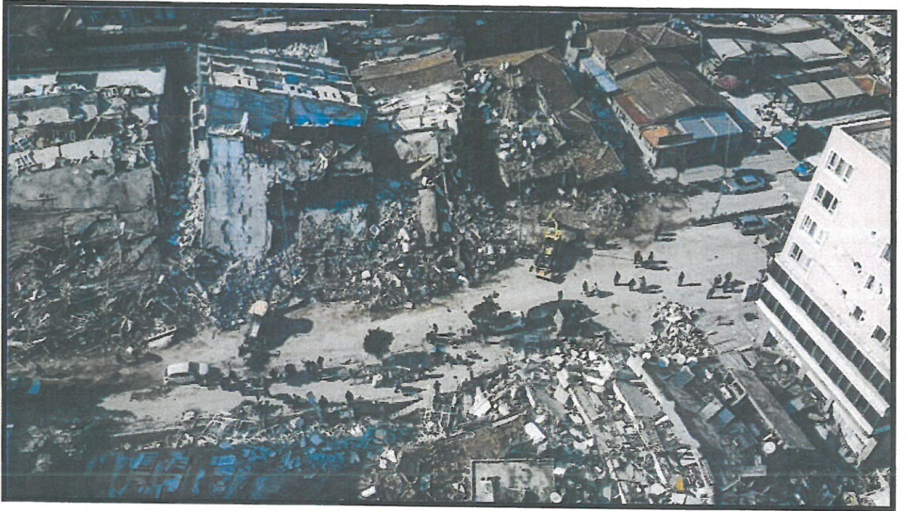
Şekil 10. 6 Şubat 2023 Kahramanmaraş Depremi Sonucu Enkaza Dönmüş Binalar.
