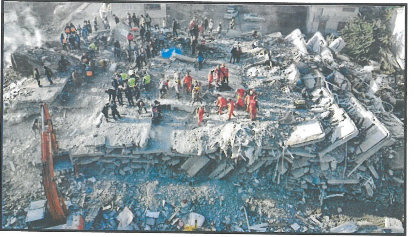
Şekil 9. 6 Şubat 2023 Kahramanmaraş Depremi Sonucu Enkaza Dönmüş Binalar.
